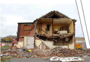
Une maison démolie dans le cadre du programme de régénération urbaine.
