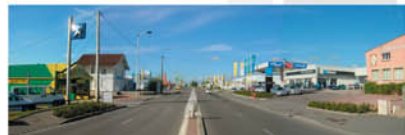
VUE GENERALE EXISTANT
