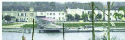
Prix arturbain.fr 2001 Mention Respect de l'Environnement - Halte pour péniches en liaison avec le bourg, Saint-Mammès sur Loing (77) « (...) avec des équipements conformes aux règles de construction dans le champ d'expansion des crues et la loi sur l'eau dans le lit mineur de la rivière.»
