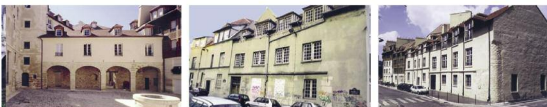
Prix arturbain.fr 2004 Mention Qualité Architecturale - L'îlot rénové de la Reine Blanche, Paris XIII e « La création d'un parc de stationnement en sous-sol des bâtiments anciens offre des places supplémentaires pour les riverains ce qui contribue à diminuer l'encombrement des rues à proximité. »
