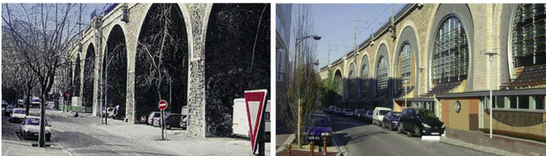
Prix arturbain.fr 2002 Prix – Sous les arches, Issis-les-Moulineaux (92) « Le ravallement du viaduc a mis en valeur la pierre meulière et la pierre d'appareil. »
