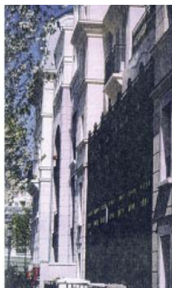
RESIDENCE DU BOIS DES VALLEES Loggia et Balcons des logements en accession à la propriété
