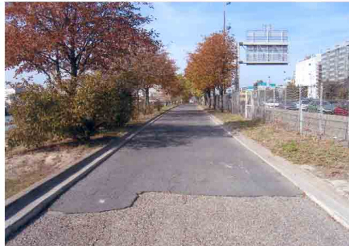
2. Piste cyclable à proximité de l'autoroute
