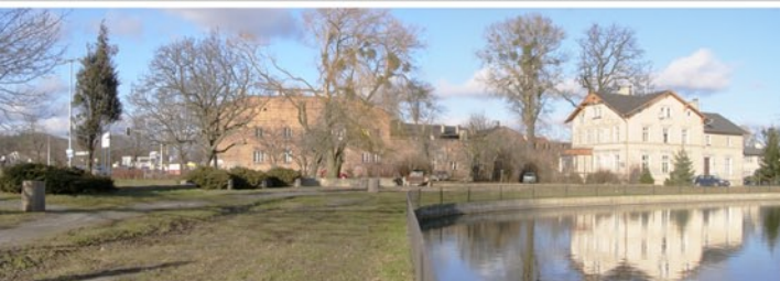
1. un très mauvais niveau d'aménagement de la rive de l'étang
