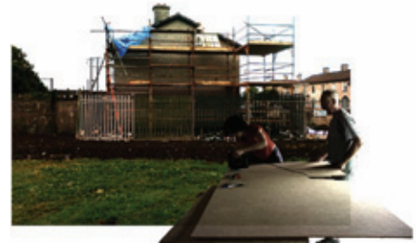
coopérative de construction
