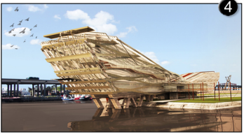
création d'un terminal audiovisuel qui maintient l'esthétique imposée et re fonctionnalise lieu
