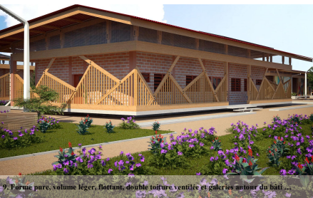
9. Forme pure, volume léger, flottant, double toiture ventilée et galeries autour du bâti...
